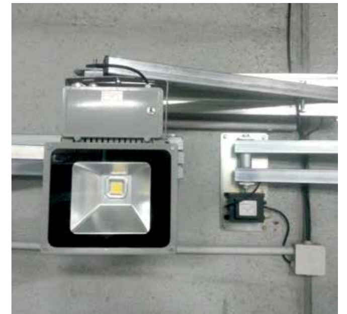
Lámpara para muelles de carga un accesorio adecuado para iluminar el interior de los vehículos durante las maniobras.
