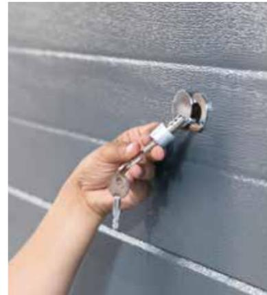
Außen Notentriegelung mit Schlüssel (Deckenantrieb)
